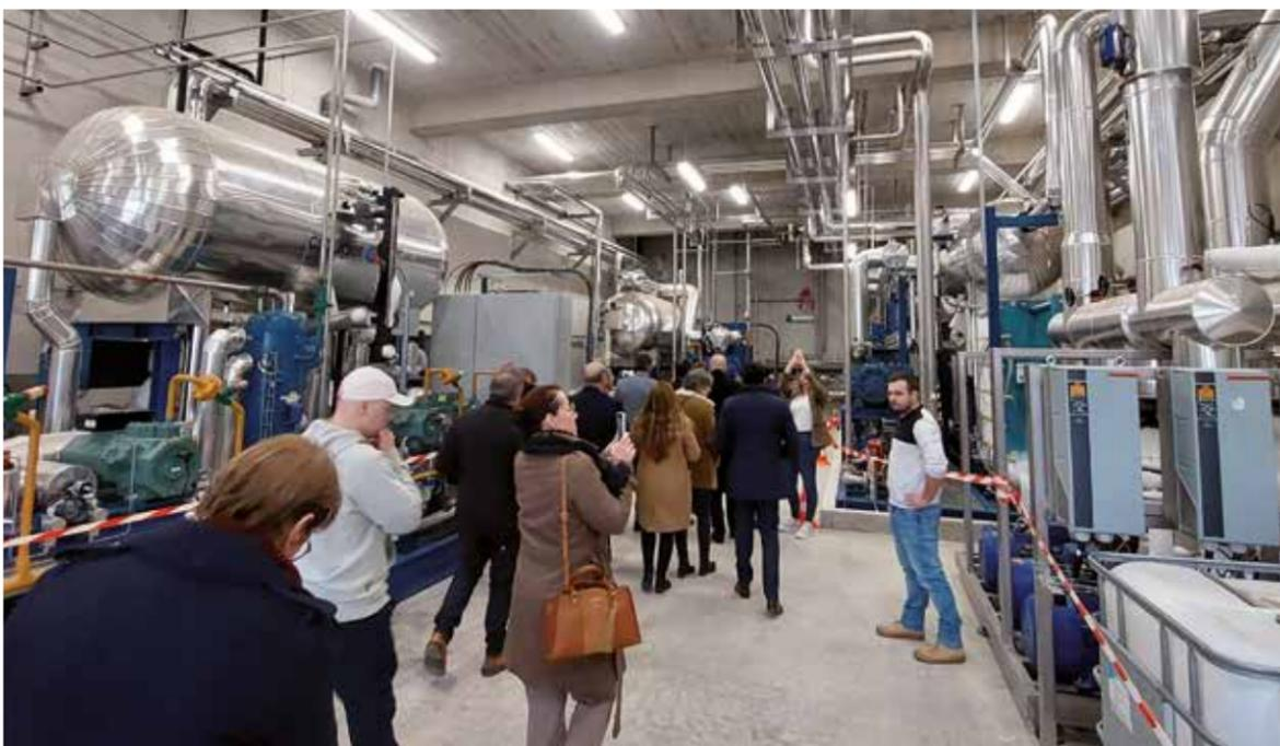
La salle des machines : aucune production de chaleur, tout se fait par récupération de l'énergie dégagée par le groupe froid.
